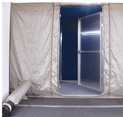
正面扉 取付時
