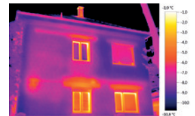
スケールアシストあり 適正化されたスケールで建物の温度が表示され、最高 / 最低温度箇所を見つけやすい
