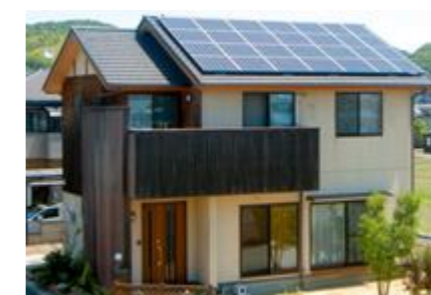
家庭用太陽光発電システム
