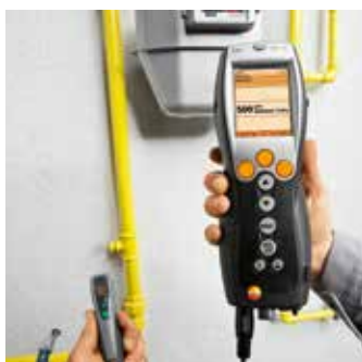
ガス漏れ検知プローブを使い、パイプライン周辺のガス漏れを確認
