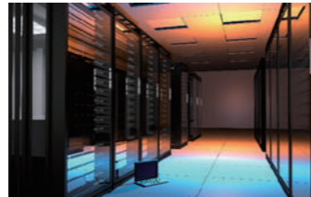
データセンター熱マネジメント
