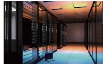
データセンター熱マネジメント
