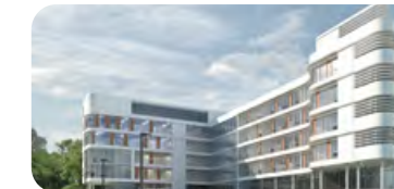
スマートビル
