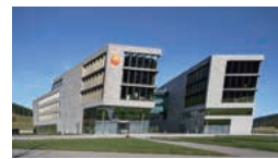
ドイツ Testo SE & Co. KGaA 本社ビル
