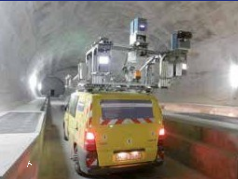
トンネルのキネマティック測量
