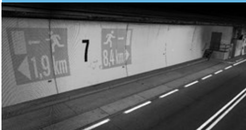
アールベルグストラセントトンネル;高性能のレーザースキャナーとカメラによるトンネル表面の連続性データと表面状態の検査
