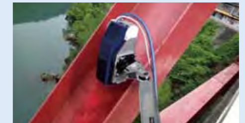
橋梁のメンテナンス
