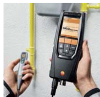
ガス漏れ検知プローブを使い、パイプライン周辺のガス漏れ確認
