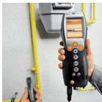
ガス漏れ検知プローブを使い、パイプライン周辺のガス漏れを確認
