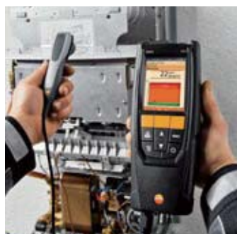
大気COプローブを使い、燃焼設備周辺にCOガスの漏れがないかを確認
