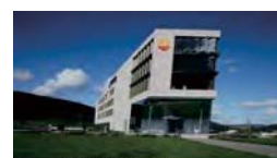
ドイツ Testo SE & KGaA 本社ビル
